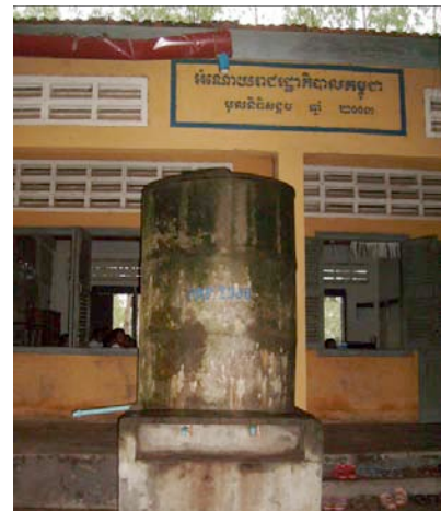
雨水が溜まるようになっている
